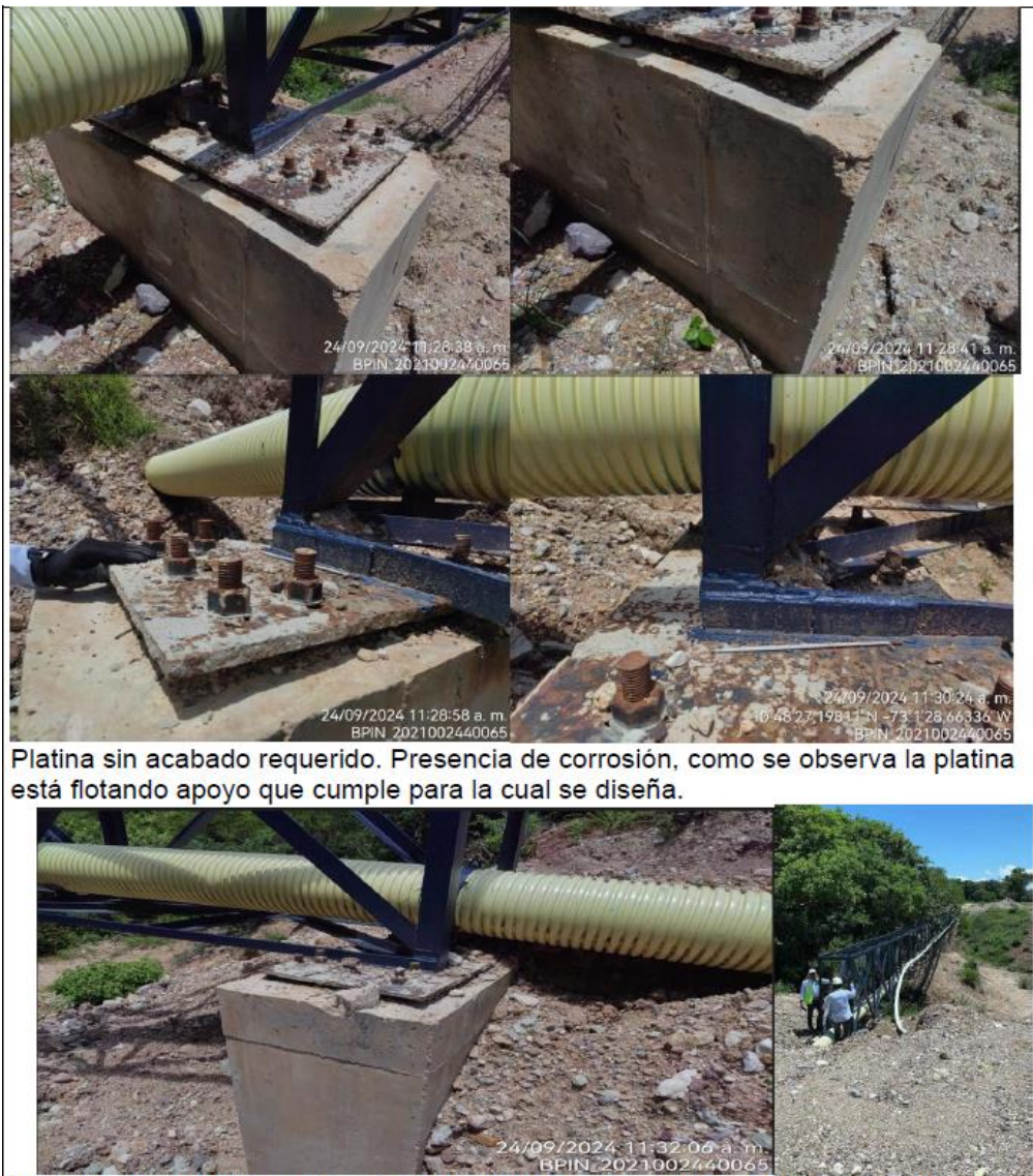
Material incorporado en el pedestal de concreto con sobre tamaños. Se observo corrosión en la platina, abrasión.
