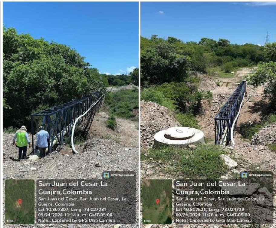
El equipo auditor observa que es una estrutucra fabricada en angulos, de paso de redes de agua residual y agua para consumo humano.
